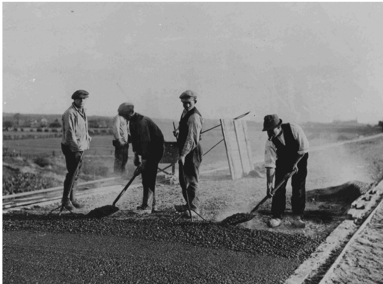
Werkzaamheden bij de aanleg van het Maas-Waalkanaal (Bron: Regionaal Archief Nijmegen)
